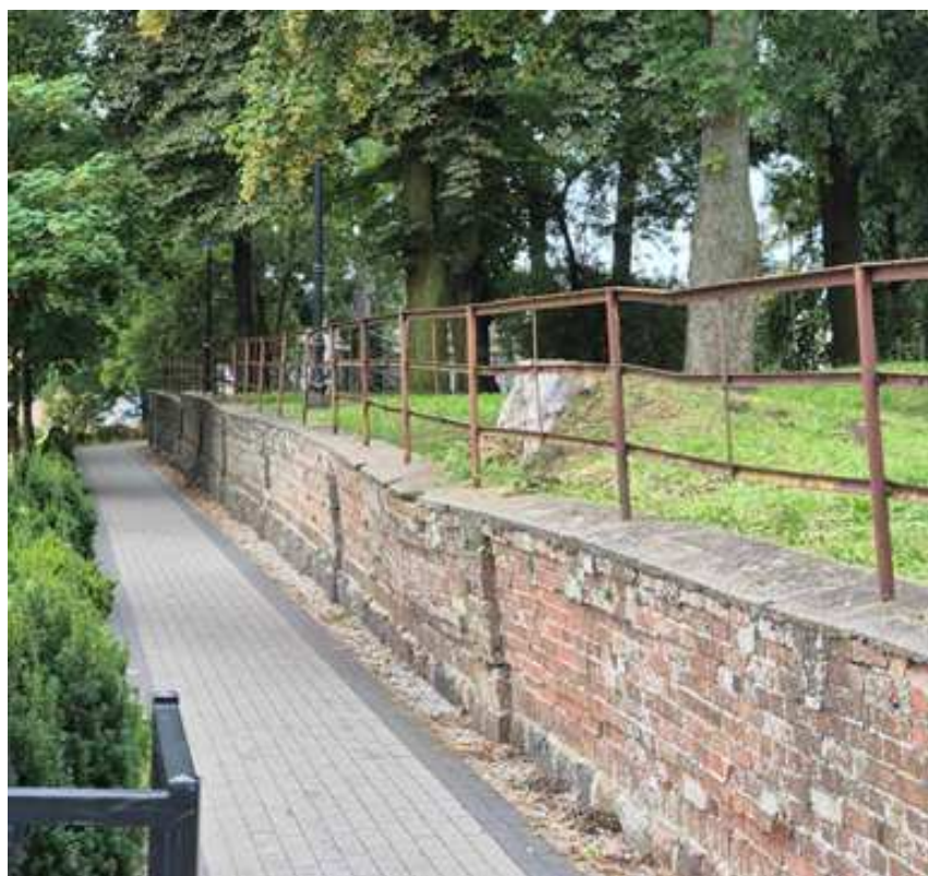
Fot. 2 Fragment muru na odcinku D-E -znaczące odchylenie od pionu
