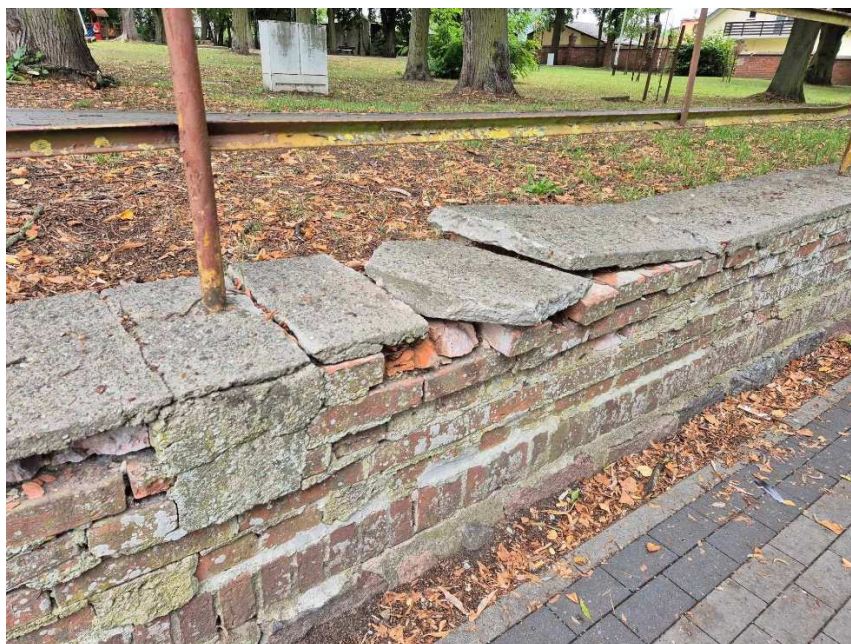
Fot. 1 Zdegradowany murek na odcinku E-F (zniszczona czapka betonowa, znaczące uszkodzenia cegły)
